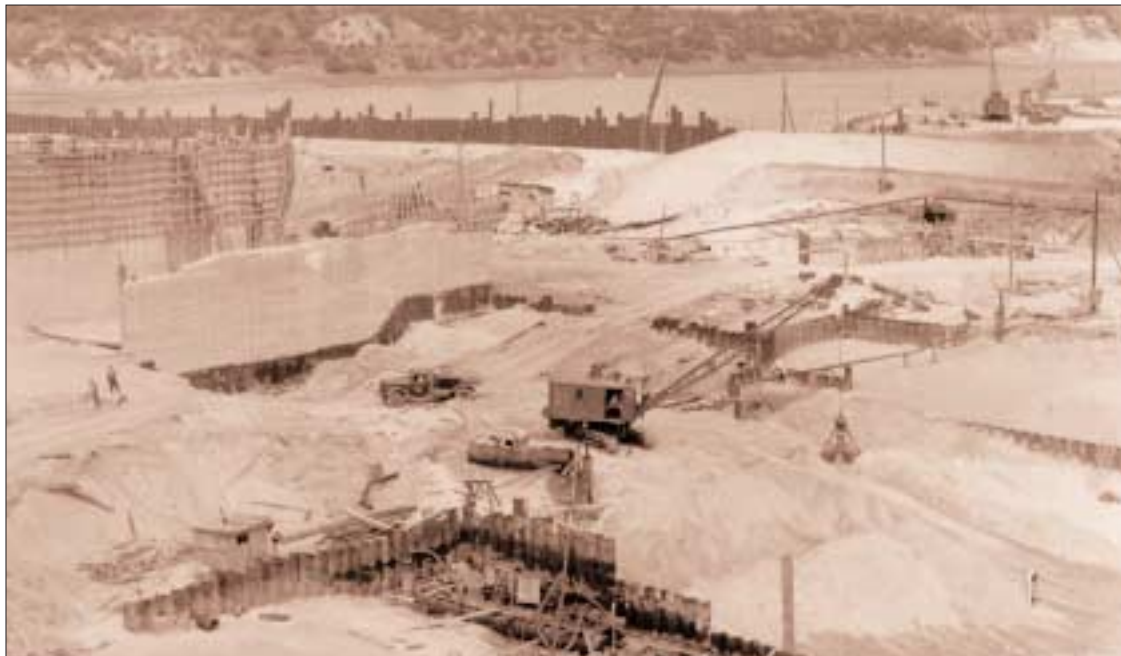
Pomału z wielkiego placu budowy...
