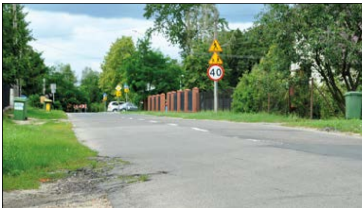
Jeszcze w tym roku ulica Szkolna w Izabelinie ma szansę zyskać nowe oblicze, a co najważniejsze - nowy system odwodnienia drogi
